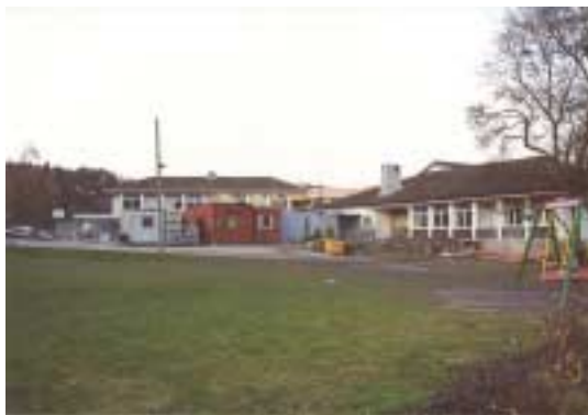
Figur 14 Bildet viser selve skoleplassen, et lunt oppholdsareal mot sørvest. Skolen er her under utbygging.
